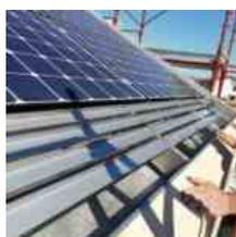
Cotto3 permette d'integrare i pannelli fotovoltaici portandoli al livello del rivestimento laterizio.
