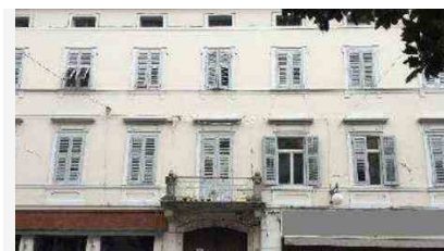
Appartamenti Gorizia Oberdan - 55605
