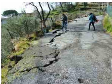
Figura 2 – Rilevamento della fratturazione cosismica che ha interessato una strada alla periferia ovest di Fleri.
