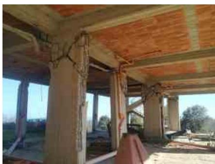
Figura 5 – Grave danneggiamento di pilastri in cemento armato in un fabbricato realizzato sopra la faglia di Fiandaca.
